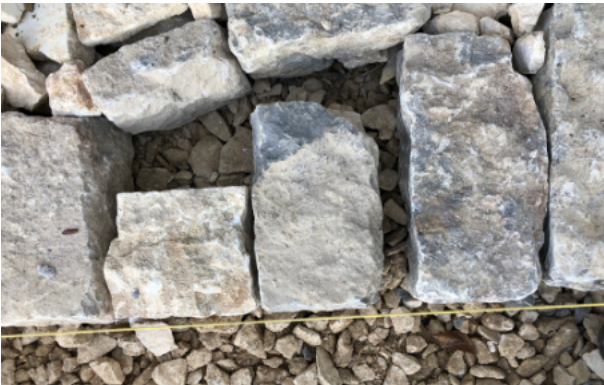
Fundamentsteine werden sorgfältig gesetzt und angepasst.
