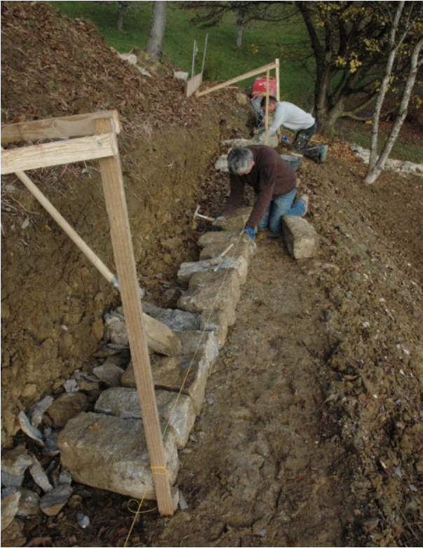
Fundamentsteine werden sorgfältig gesetzt und angepasst.
