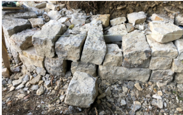
Fundamentsteine werden sorgfältig gesetzt und angepasst.
