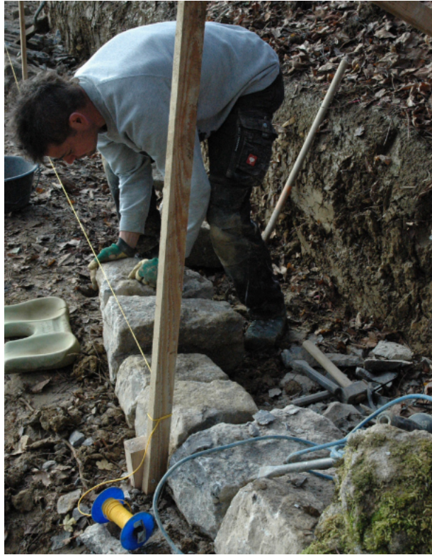
Fundamentsteine werden sorgfältig gesetzt und angepasst.
