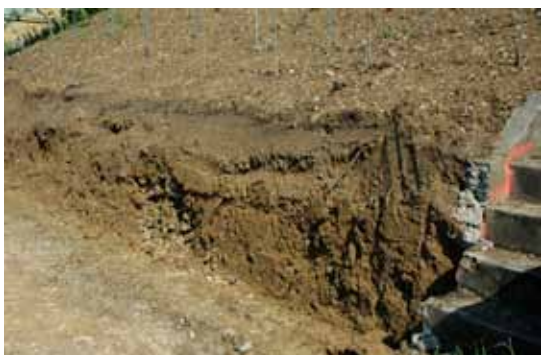
Oberhalb der Mauer wird abhumusiert.
