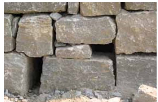
Eine Igelburg ist im Bau.
