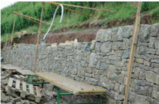
Bei hohen Mauern braucht es ein Gerüst.
