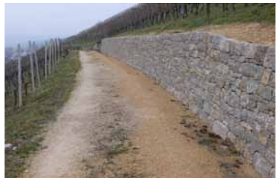
Die Oberflächen der Mauern werden auf Bewegungen untersucht.
