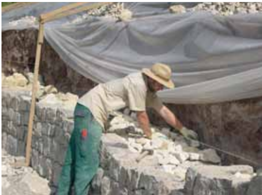
Bindersteine verankern die Mauer nach hinten.
