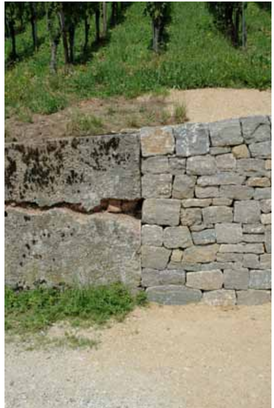
Die Übergänge zwischen alten und neuen Mauern werden beobachtet.
