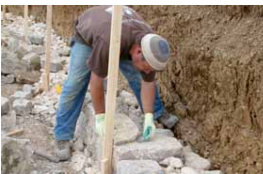
Die Fundamentsteine werden sorgfältig verlegt. Jeder Stein muss sitzen.
